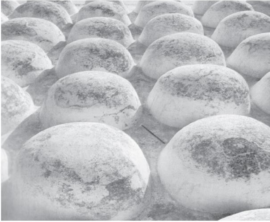
شكل (6) يوضح نظام التسقيف على العقود المتقابلة لكل أربعة عقود قبة وجميعها
